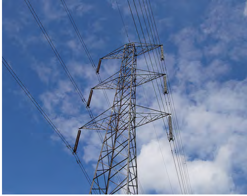
'n Spantoring ('pylon' in Engels) is 'n raamstruktuur wat elektriese hoogsenningsdrade ondersteun. 3
