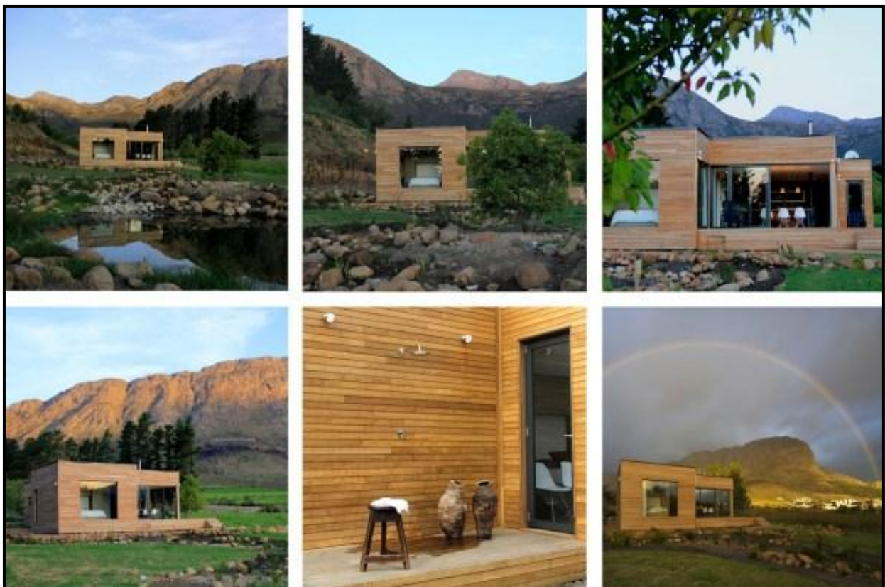
FIGUUR 8b: Pietro Russo, Eco Home (Ekohuis) , Franschhoek, Suid-Afrika, 2014. Verskillende aansigte van dieselfde huis. Vooraf in 'n fabriek in Suid-Afrika vervaardig en daarna na sy ligging vervoer.
