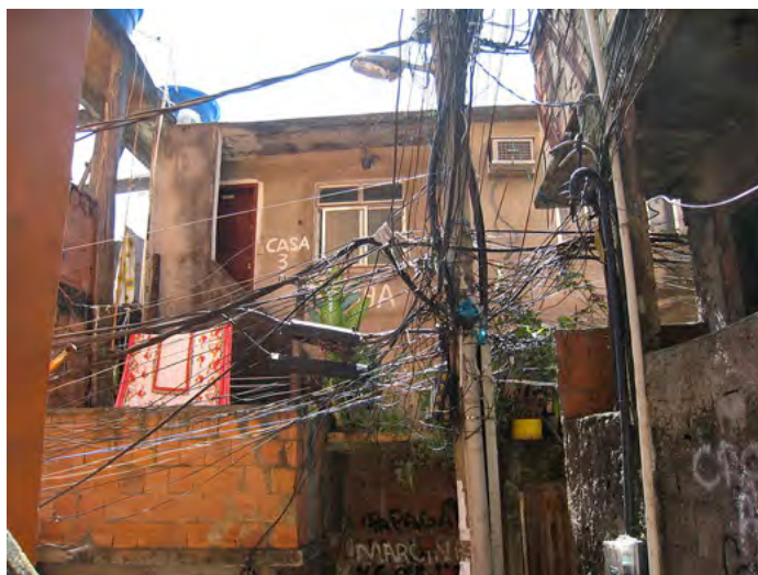
Kyk na hierdie gemors van onwettige elektriese skakelings. 4
