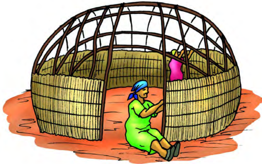
Vroue maak die rietmatte aan die raamwerk vas.
