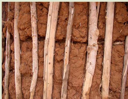
Die muur van 'n modderhuis met 'n stokraam. 2
