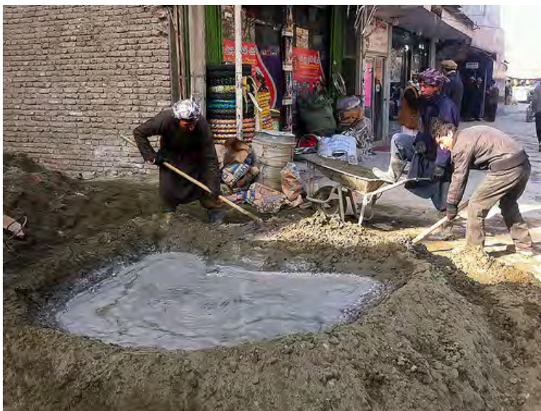
Grawe word gebruik om sement te meng.
