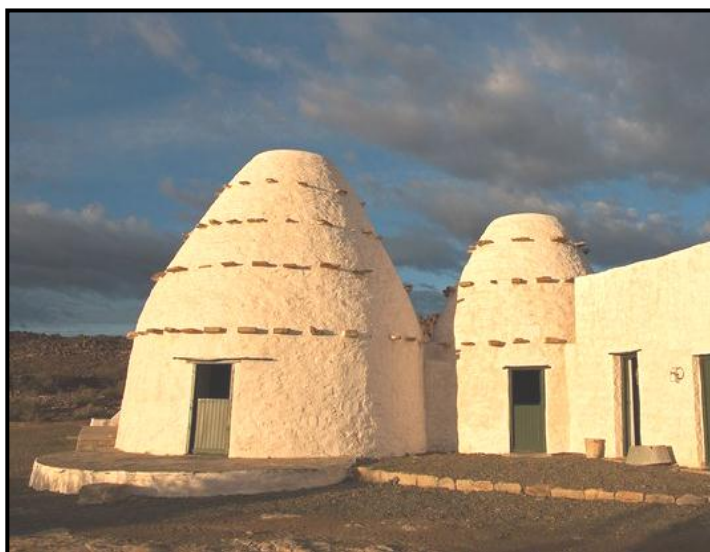
FIGUUR 8a: Witgekalkte korbeelhuse (' corbelled houses '), klip, modder en klei, Stuurmansfonteinplaas, Karoo, 19 de eeu (deur nomadiese boere gebou)
