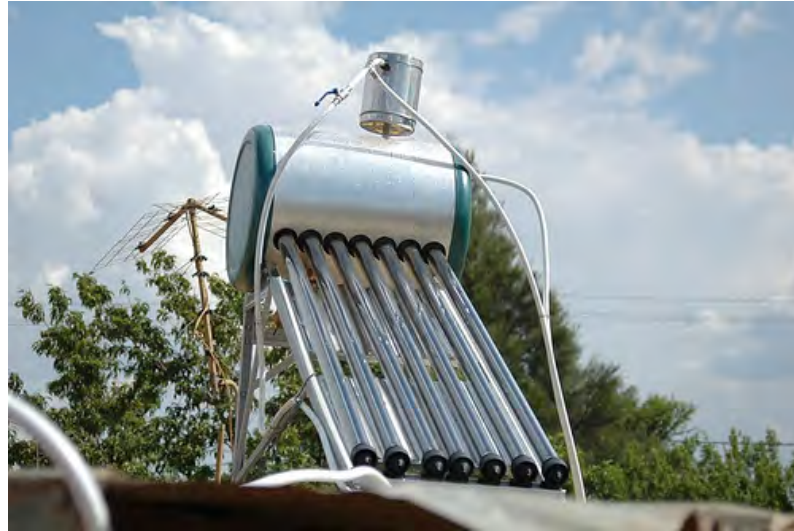
'n Son-waterverwarmer op die dak van 'n huis. Die water is in die tenk. 5
