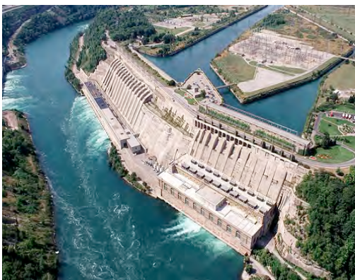
'n Groot hidro-elektriese kragstasie. As die water van die hoë dam deur die stasie na die onderste dam vloeï, word elektrisiteit gemaak. 5
